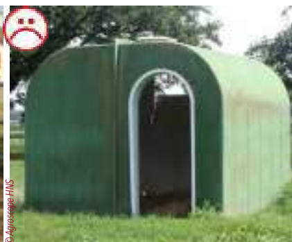
Abris dont l'entrée unique et de taille insuffisante permet à un individu dominant de bloquer l'accès aux autres chevaux.
